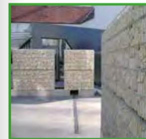
Formstabiles Bauwerk aufgrund stabilem Doppelstabsystem.
