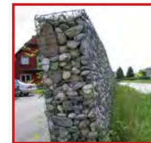
Neigung der Mauer aufgrund mangelnder Verdichtung und filigranem Gittersystem.
