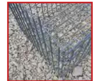
Die Stanz- und Schweißstellen stellen ein Problem bei galvanverzinkten Bauteilen dar, da jede dieser Stellen eine Schwachstelle im Korrosionsschutzsystem darstellt und es dort nach wenigen Jahren zur Korrosion kommt.
