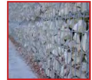
Erhebliche Ausbuchtungen durch Materialsetzungen ohne Verdichtung in Kombination mit filigranem Gitter.
