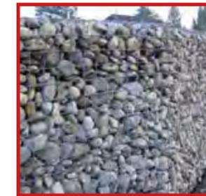
Instabilität durch filigranes Gitter (ermöglicht keine nachträglichen Reparaturen).
