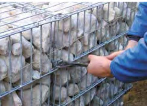
**5** Seitlich mit Klammern verbinden (die Klammern werden oberhalb eines Querstabes gesetzt).
