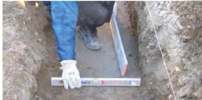
**1** Waagrecht und ebener Unterbau (auf verdichtetem Schotterboden oder auf Magerbeton).
