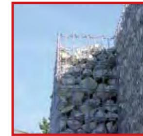
Nachträgliche Setzungen und Verformungen durch mangelnde Verdichtung.
